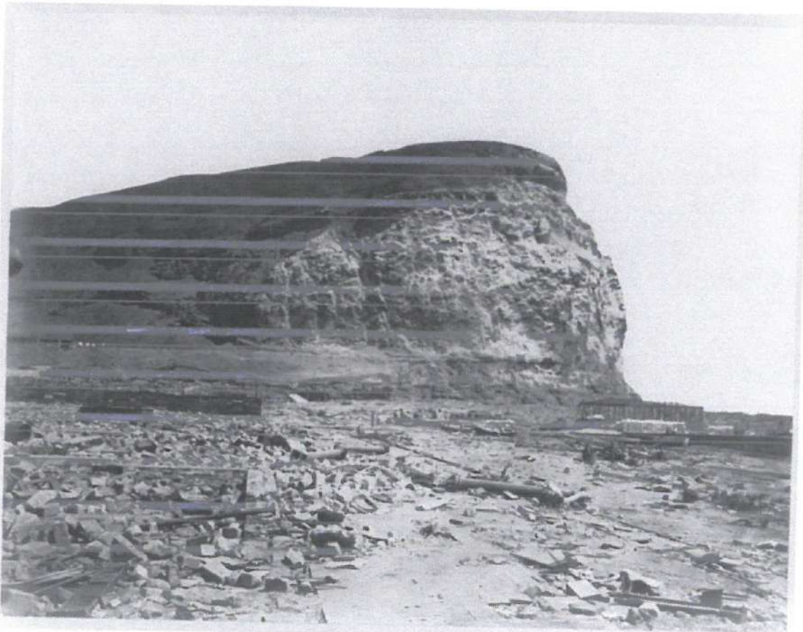
El morro de Arica después del terremoto
